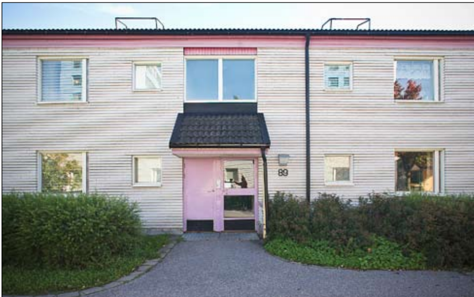
Entrépartier i olika färger med skärmtak täckt med svart betongtegel. Foto Mattias Ek. Ldng20100419
