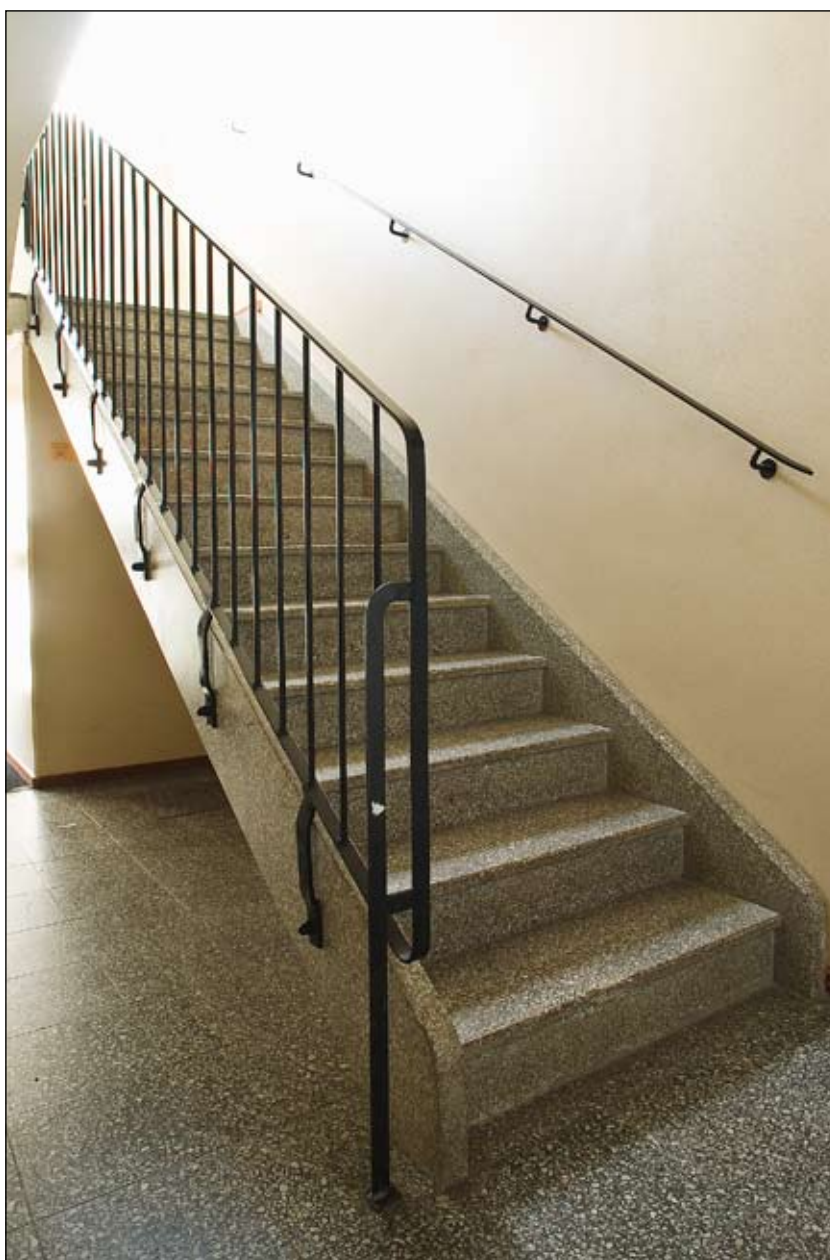
Trapphus med plan och trappor av cementmosaik. Svartmålade handledare och räcken. Foto Mattias Ek. Ldng20100375
