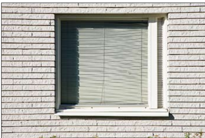
Vita plåtinklädda fönstersnickerier. Foto Mattias Ek. Ldng20100414
