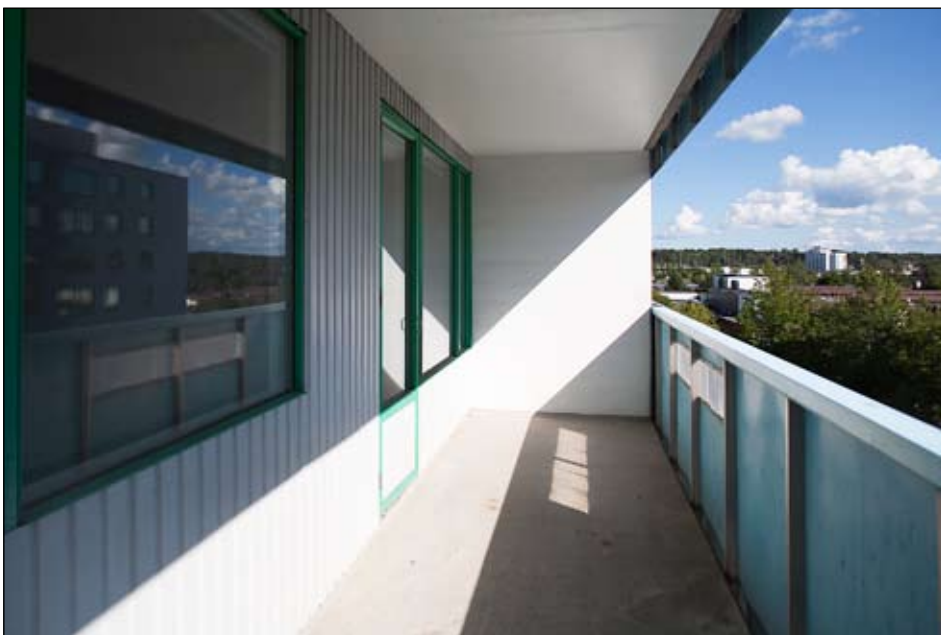
Fasaderna innanför balkongerna är klädda med vit korrugerad plåt. Fönstersnickerierna och balkongdörrarna av grönmålat trä har inte klätts in med plåt. Foto Elisabeth Boogh. Ldng20100319
