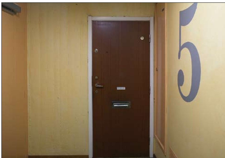
Lägenheternas fanerade dörrar kläs efterhand in med träimiterande plastfilm. Foto Elisabeth Boogh. Ldng20100342
