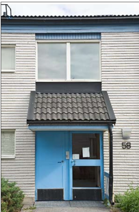
Entrépartier i olika färger med skärmtak täckt med svart betongtegel. Foto Mattias Ek. Ldng20100419
