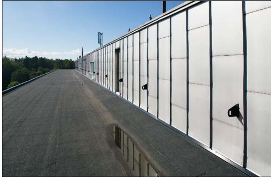
Takbeklädnad av asfaltpapp och överbyggnad inklädd med ofärgad falsad plåt. Foto Elisabeth Boogh. Ldng20100340
