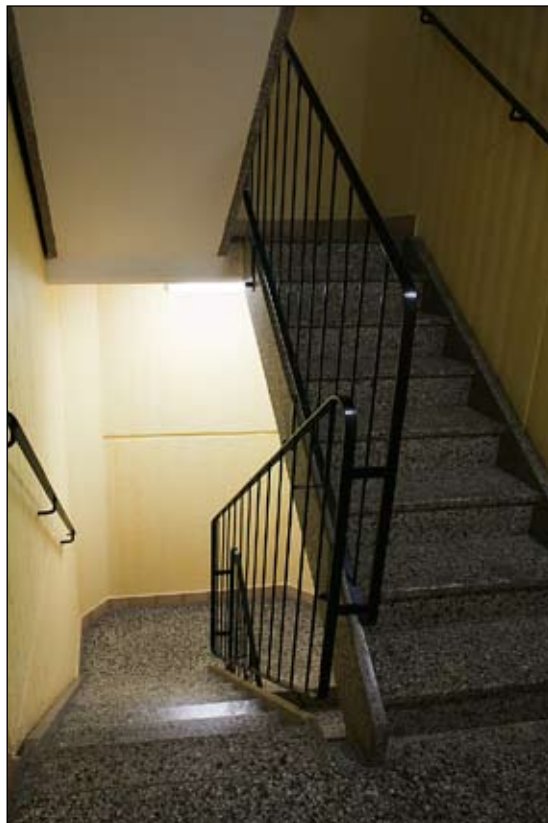
Trapp- och vilplan av cementmosaik och handledare och räcken av svartmålat järn. Foto Elisabeth Boogh. Ldng20100341
