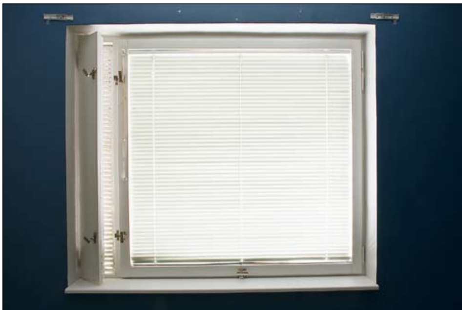
Köksfönster med vädringsruta och öppningsbeslag från byggnadstiden. Foto Mattias Ek. Ldng20100359
