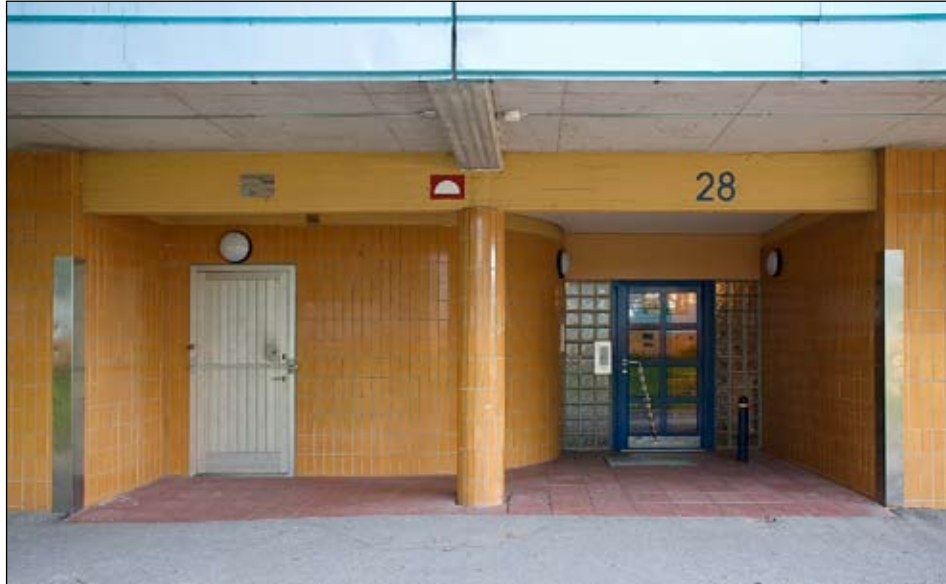
Entrépartier med pelare klädda med gult kakel. Portarna har bytts ut. Foto Mattias Ek. Ldng20100421
